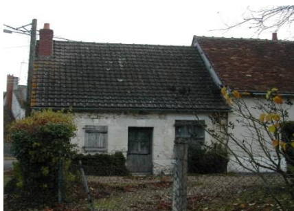
Logement de l'institutrice
