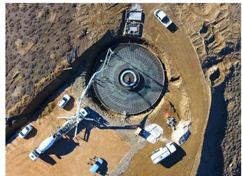
Culminant à 190 m de hauteur, les nouvelles éoliennes de Pougny, au nord de la Nièvre, s'ancrent solidement dans le sol grâce à d'énormes socles de béton.
