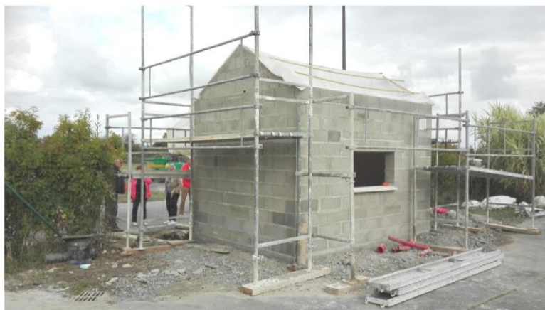
La station de surpression en construction
